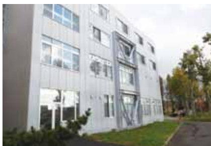
■函館5号館改修工事
