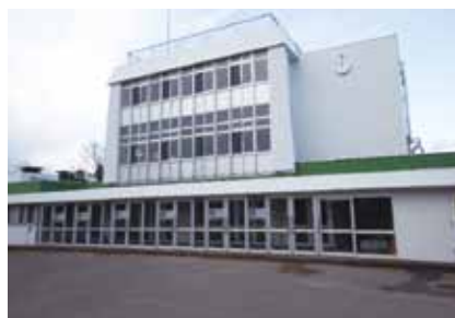
■附属旭川小学校校舎改修工事
