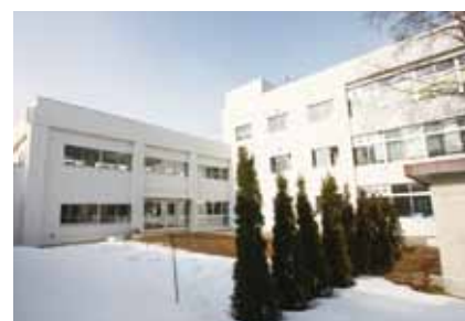
■附属函館小学校校舎改修工事
